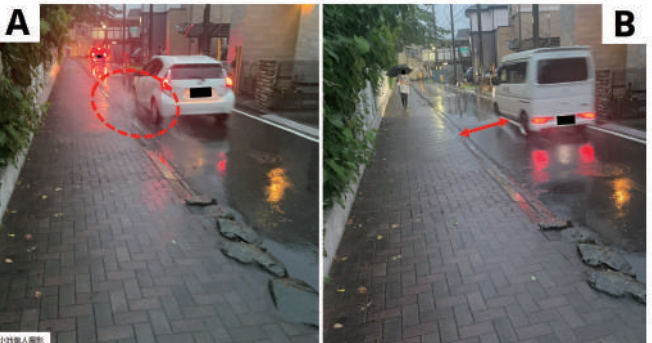
上尾小学校周辺でも各所で内水による道路浸水が発生。Aのような水撥ねが起こっている箇所が複数ある。Bのように浸水箇所を避ける蛇行運転は接触事故のリスクも高まる。
